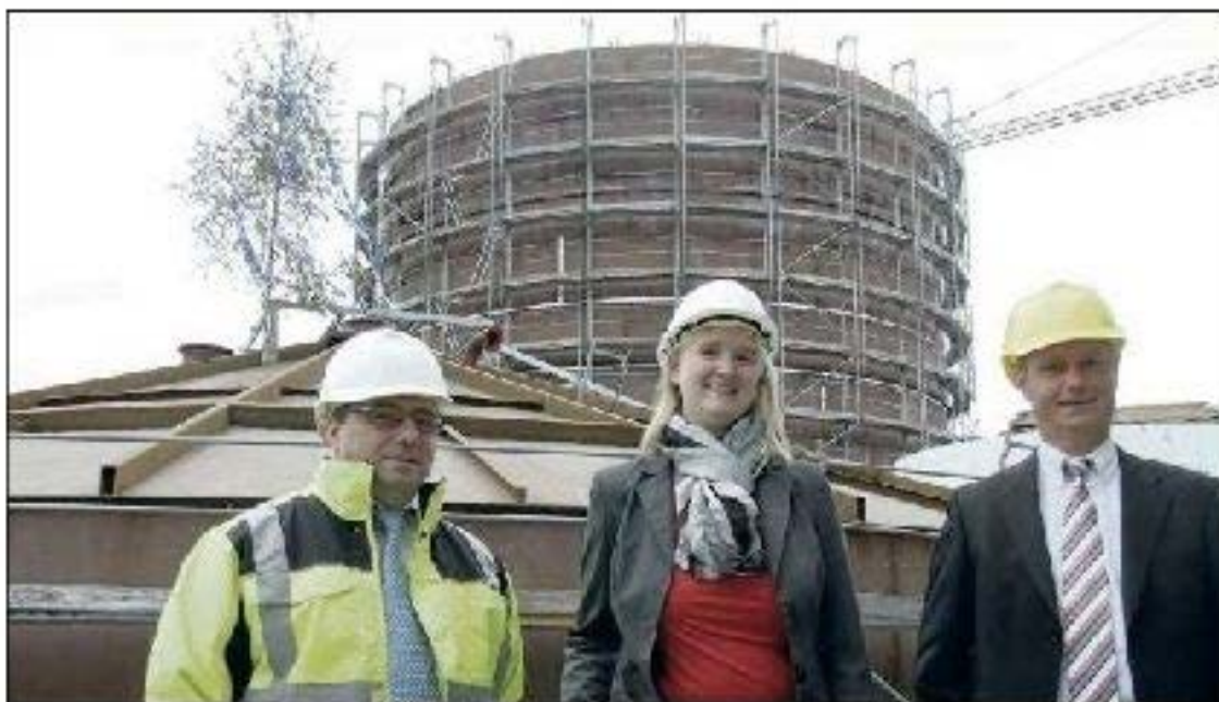
Am Dienstag kommt der Deckel drauf: Eric Priller (Energy Solutions), Carolin Böhme (Städte- und Industriereinigung) und Reinhard Dietel (rsb Bioverwertung Hochfranken) führten über das Gelände.
